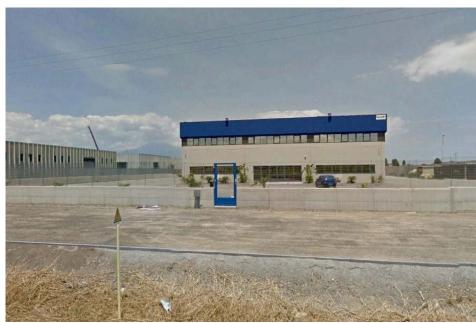
struttura è costituita da un corpo prospiciente il fronte strada di superficie coperta pari a 261,00mq e altezza 6.40m ed un corpo retrostante di superficie maggiore pari a 939,00mq e altezza 8.00m.
