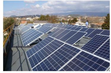
L'impianto sarà installato sulla copertura a terrazza della Confraternita comunale e verrà collegato alla rete elettrica ENEL (Tipo "Grid-connected").
